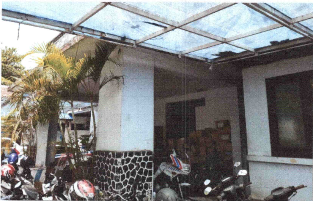
Foto 5. Foto ini menggambarkan wajah bangunan baru, dimana kontruksi bangunan dan arsitektur pada kusen dan jendelanya juga telah disesuaikan dengan bangunan lama, serta ada tambahan atap canopy (Sumber: Dokumentasi TACB Kab. Banyumas)
