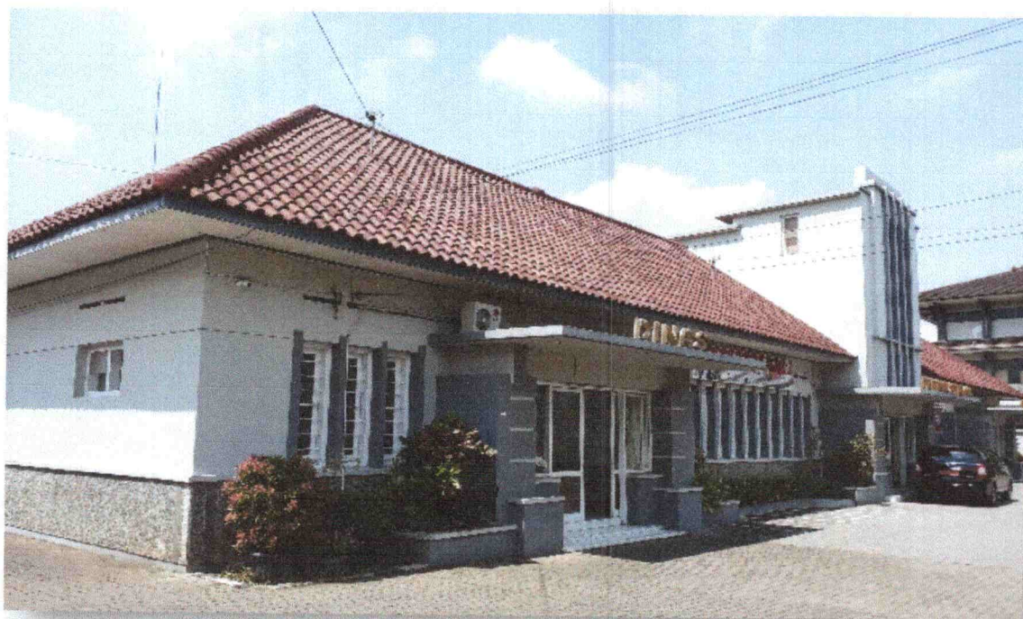
Foto 3. Fasade depan Gedung Dinas Perindustrian dan Perdagangan Kabupaten Banyumas pada bagian sisi kiri. (Dokumentasi : TACB Kabupaten Banyumas, 2019)
