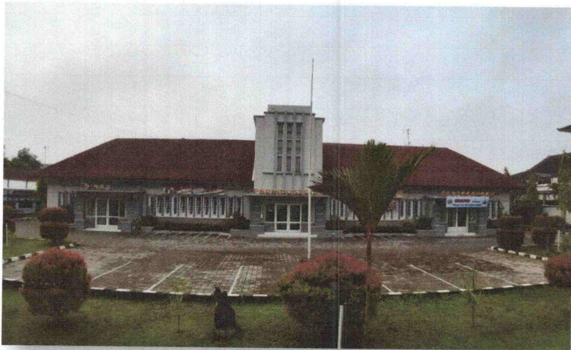
Foto 2. Fasade depan bangunan gedung Kantor Dinas Perindustrian dan Perdagangan Kabupaten Banyumas pada saat ini. (Dokumentasi : TACB Kab. Banyumas, 2019).
