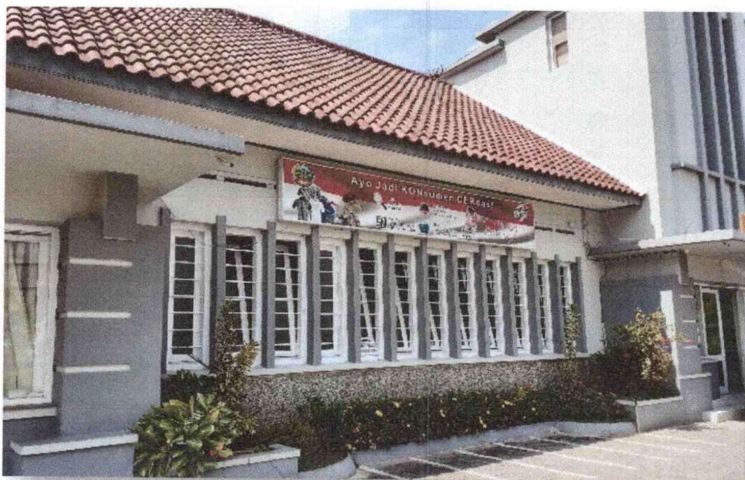
Foto 7. Fasade depan bangunan terdapat banyak bukaan jendela untuk penghawaan dan penerangan alami. ( Dokumentasi : TACB Kabupaten Banyumas, 2019 )
