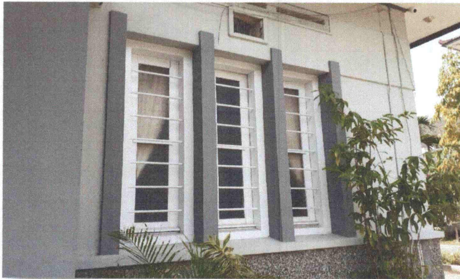
Foto 10. Bentuk kusen dan bukaan daun jendela di sisi kiri dan kanan bangunan bagian depan untuk penghawaan dan penerangan alami (Dokumentasi : TACB Kabupaten Banyumas, 2019)
