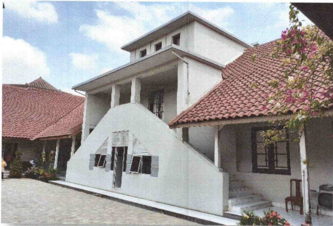
Foto 6. Fasade belakang bangunan Kantor Disperindag. Menghadap ruang terbuka ( inner court ) di halaman belakang. Terdapat tangga menuju lantai kedua ( Dokumentasi : TACB Kabupaten Banyumas, 2019 )
