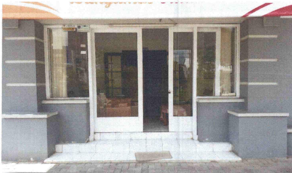
Foto 11. Bentuk kusen dan bukaan daun pintu utama bangunan bagian depan. Diduga sudah mengalami pergantian bentuk dan materialnya dari aslinya. (Dokumentasi : TACB Kabupaten Banyumas, 2019)
