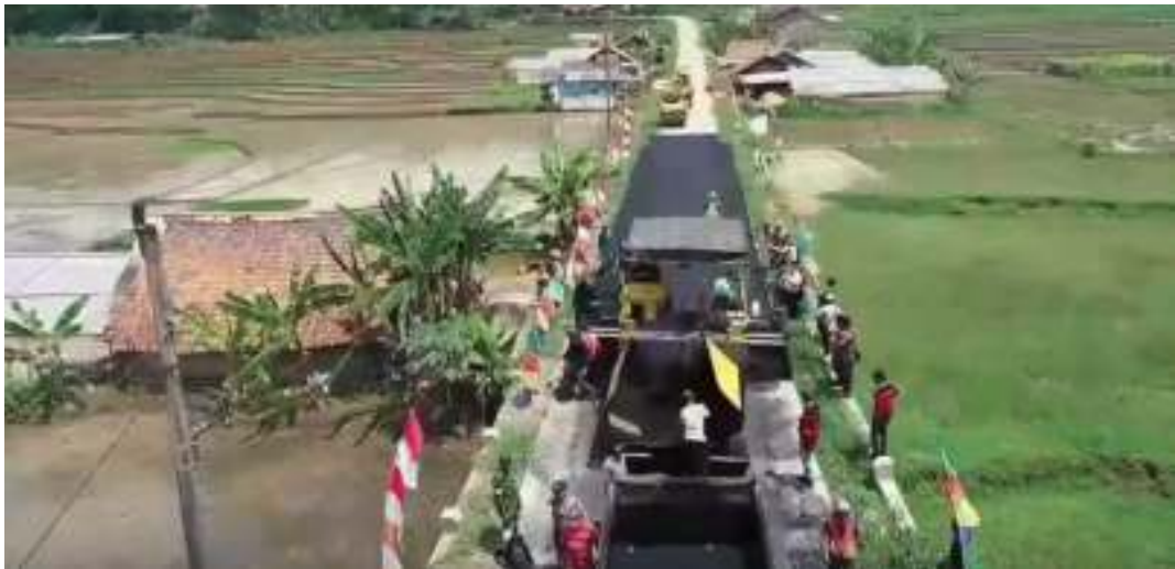
Gambar 4. 15 Pemanfaatan Limbah Plastik untuk Aspal Hotmix
