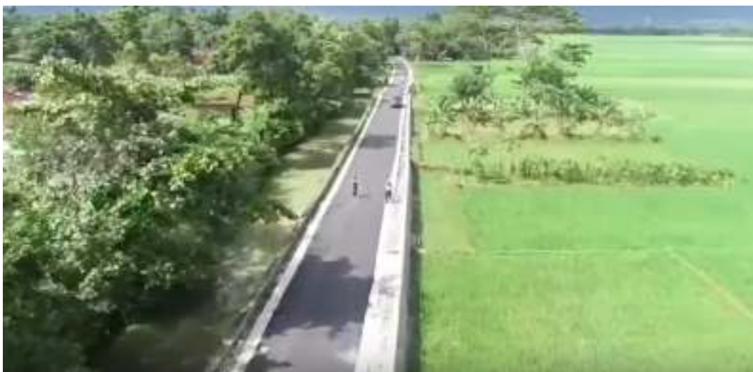
Gambar 4. 16 Jalan dengan Aspal Hotmix Campuran Limbah Plastik
