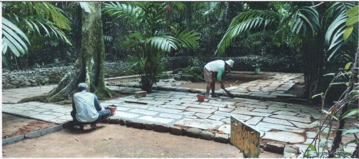
Foto 16 Proses pekerjaan pasangan batu alam sebagai lantai di Maqom Dalem Santri teras 1 (Pemeliharaan Tahun 2024 oleh Pemdes Kutaliman) Dok. TPCB Kab. Banyumas 2024
