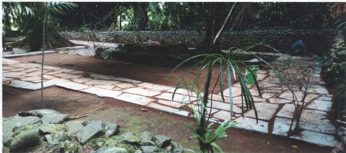
Foto 17 Area teras 1 Maqom Dalem Santri terlihat lantai dari tanah yang diperkeras berdampingan dengan lantai pasangan batu alam (Pemeliharaan Tahun 2024 oleh Pemdes Kutaliman) Dok. TPCB Kab. Banyumas 2024
