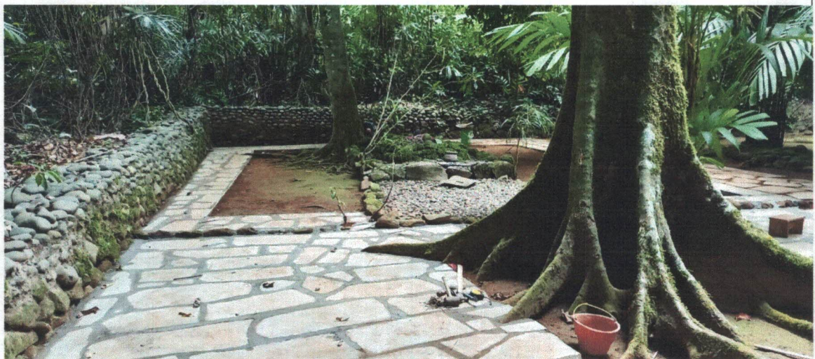
Foto 14 Lantai batu alam dipasangkan di sekitar area Maqom Dalem Santri (Pemeliharaan Tahun 2024 oleh Pemdes Kutaliman) Dok. TPCB Kab. Banyumas 2024
