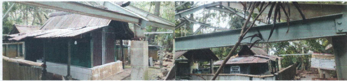
Foto 15 Struktur penutup atap makam Foto 16 Detail besi struktur Dok. TPCB Kab. Banyumas 2025
